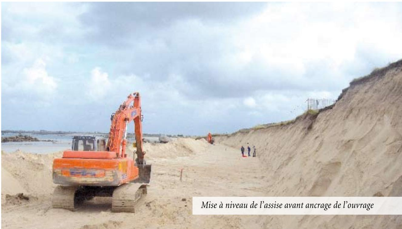
*Mise à niveau de l'assise avant ancrage de l'ouvrage*
