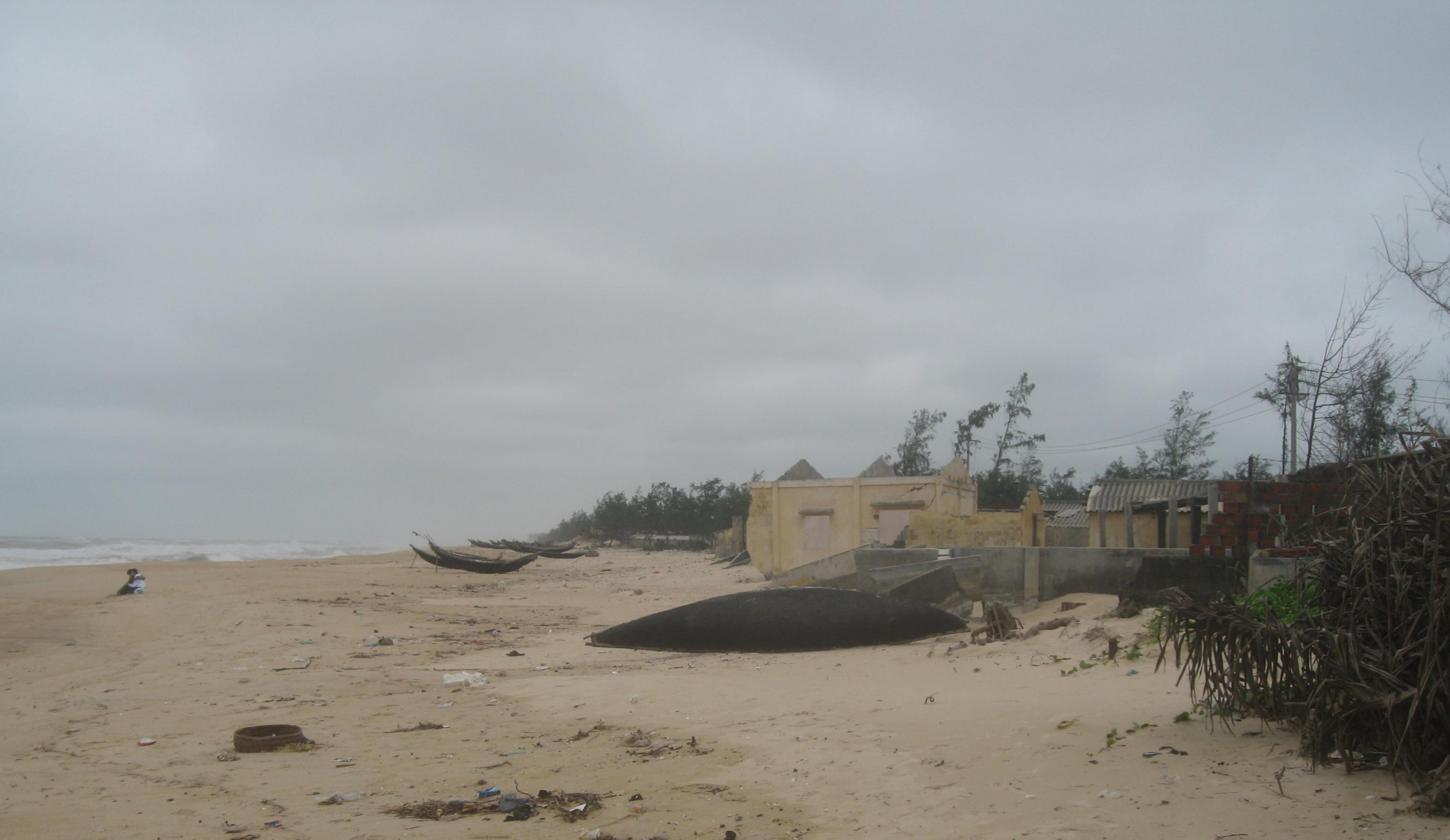
VIET NAM – Province de Thua Thien, Hue, site de Phu Thuan. Erosion du trait de côte – recul important (zone soumise aux typhons) Destruction des habitations et des infrastructures. (Photo Espace Pur mars 2007)
